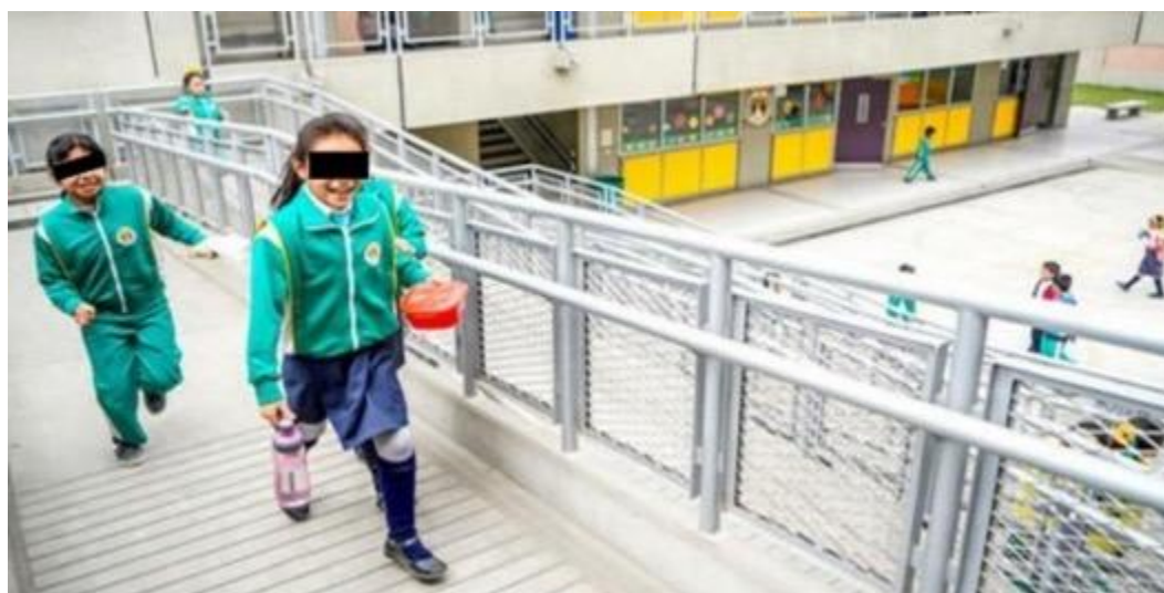
Figura 1. Accesibilidad de espacios mediante rampas
