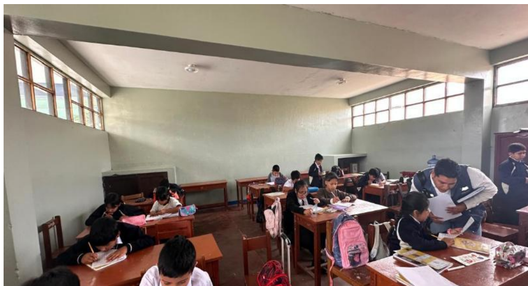
Figura 4. Estado actual del Aula de Tercero B (aula típica)
