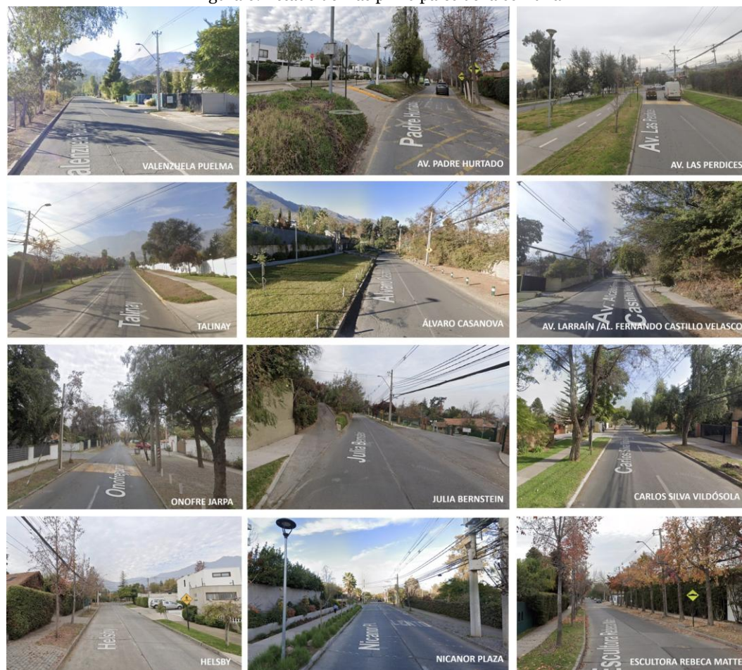
Figura 6. Estado de vías principales de la comuna
