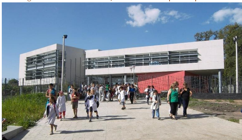
Figura 14. Vista del acceso, Escuela de Tiempo Completo 330
