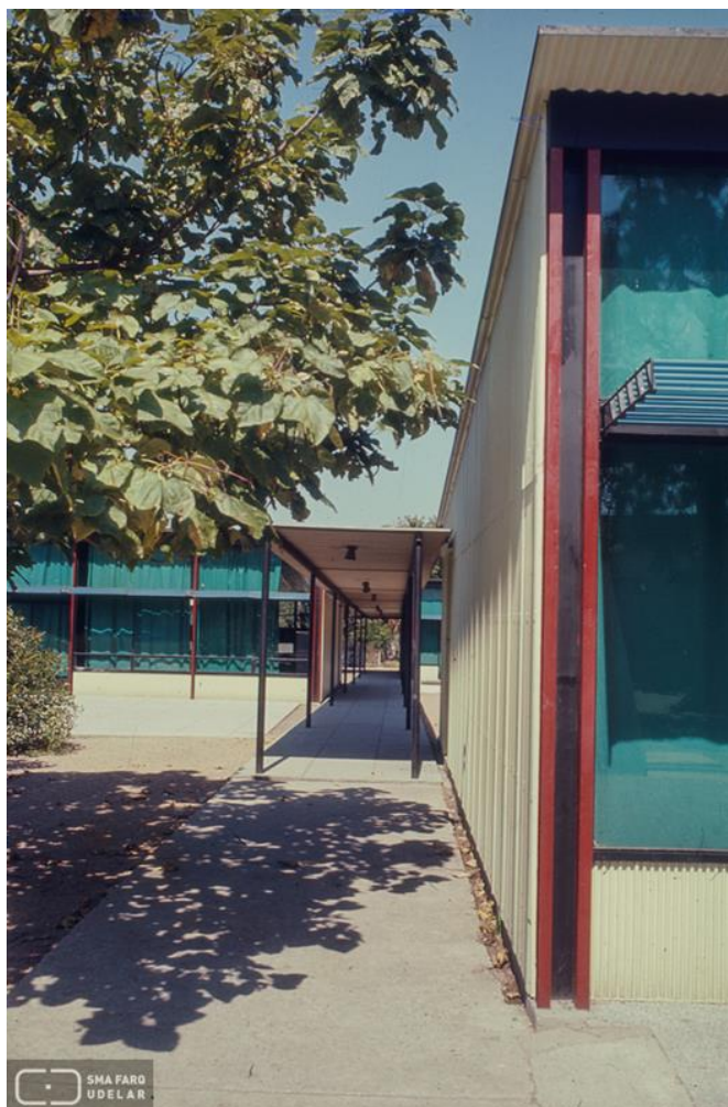
Figura 12. Vista de pasaje techado, Escuela 47/108 'Washington Beltrán'
