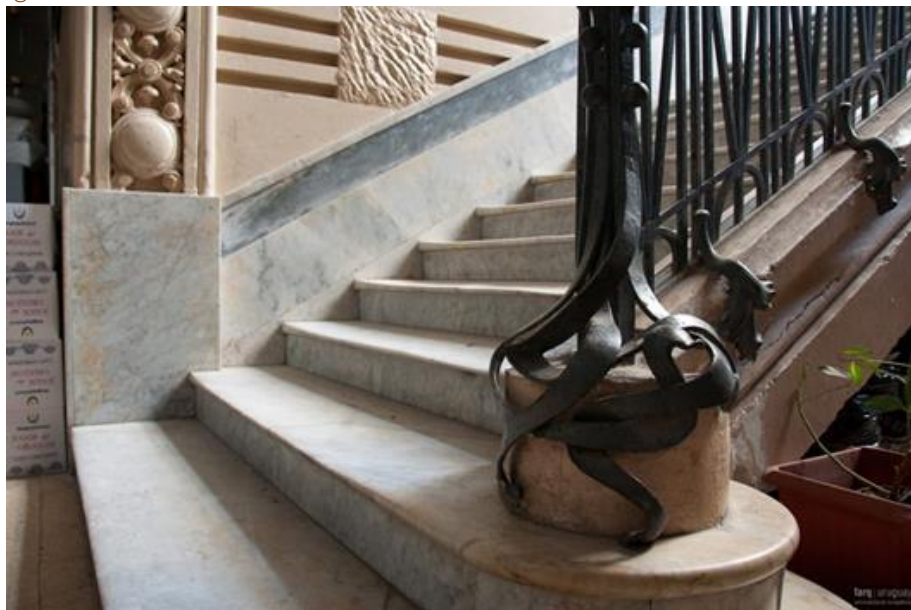
Figura 5. Detalle de la baranda de la escalera de la sección niñas de la Escuela Brasil
