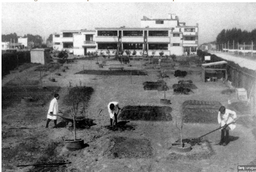
Figura 8. Vista del espacio exterior de la Escuela Experimental de Malvín
