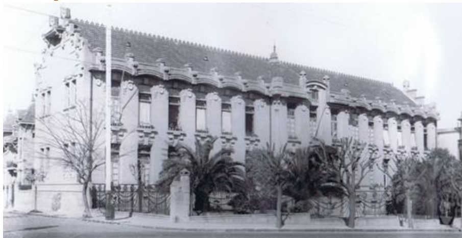
Figura 4. Vista de la fachada de la sección niñas de la Escuela Brasil
