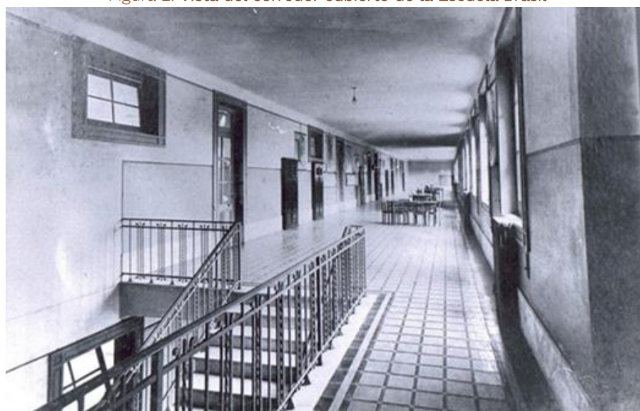
Figura 2. Vista del corredor cubierto de la Escuela Brasil
