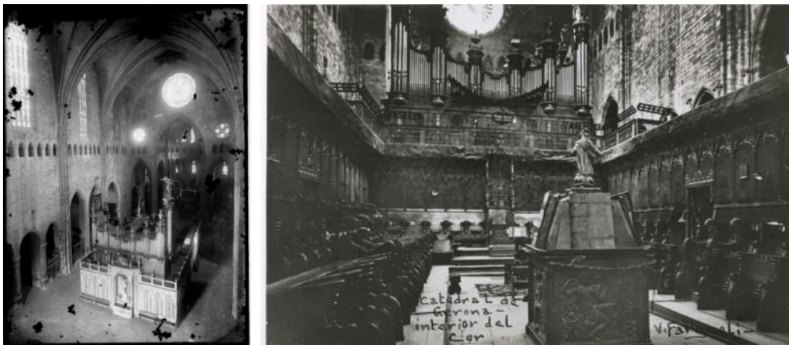
Figura 1. Configuración original del conjunto del coro en la nave central a principios del s. XX
