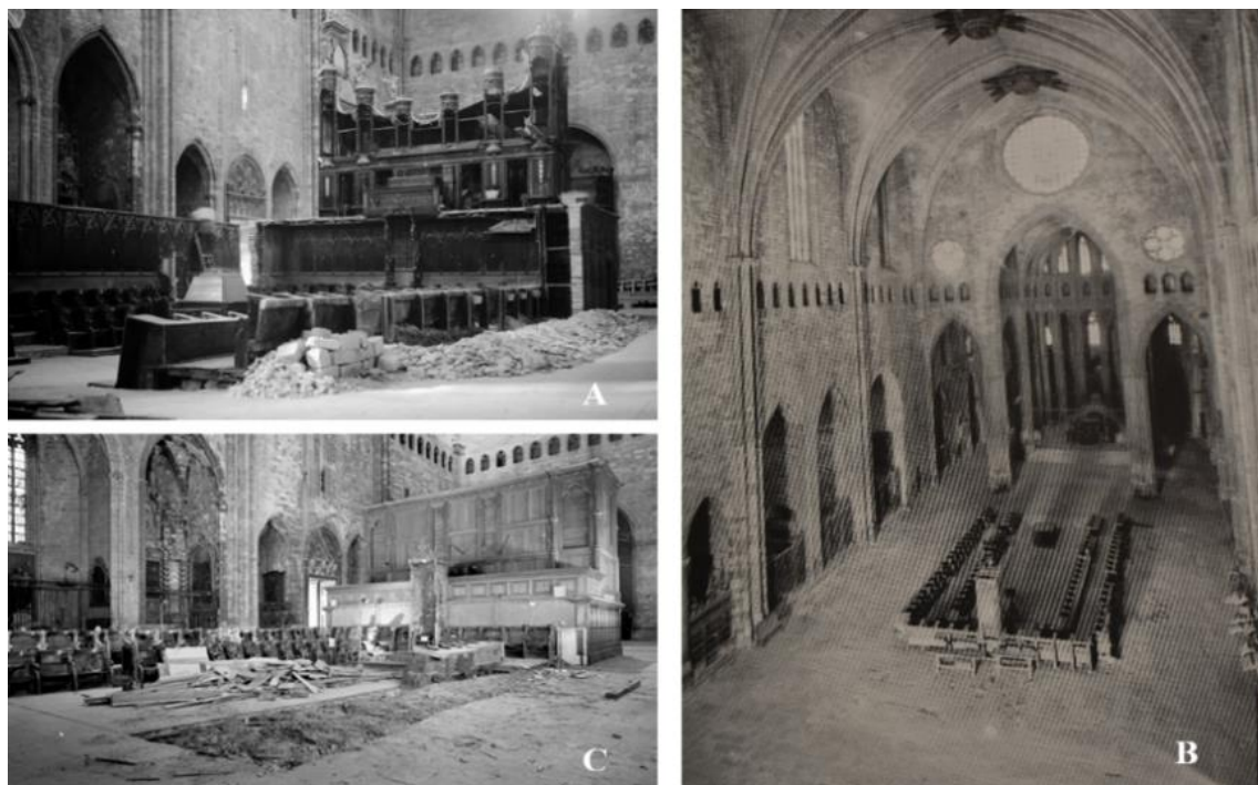
Figura 2. Proceso de derribo del trascoro en 1927
