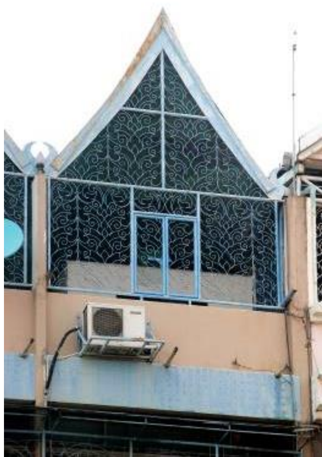
Figura 10. Azotea de una tuekthaew (c.1960s) enrejada con una cubierta añadida en forma de casa tradicional tailandesa. Se aprecia la puertezuela de evacuación antiincendios. Bangkok, 2020
