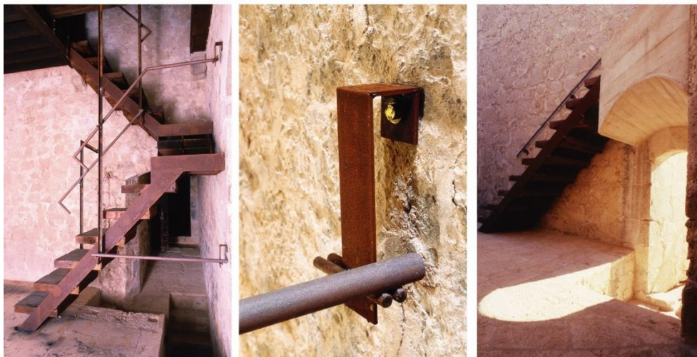
Figuras 26, 27 y 28. Reposición de accesos y detalles de ejecución. Castillo de Vélez Blanco, J. A. Molina, J. A. Sánchez Morales, Almería, España
