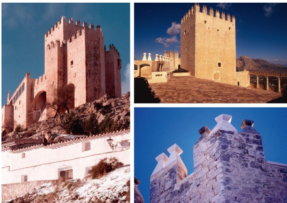
Figuras 23, 24 y 25. Imagen exterior de contexto y detalles de la intervención (reposición de almenas según ‘principio de identificación’). Castillo de Vélez Blanco, J. A. Molina, J. A. Sánchez Morales, Almería, España
