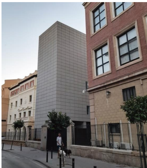
Figura 43. Imagen exterior de la intervención y su entorno. Edificio Anexo de Derecho, J. A. Molina, J. L. de Arana y M. Aroca, Murcia, España.
