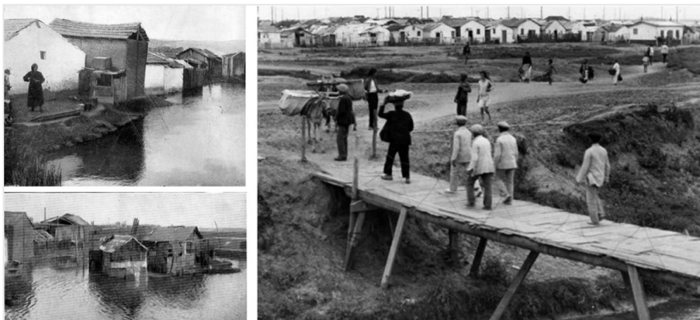
Figura 3. Asentamientos en el área previos a las construcciones de las barriadas, ca. 1940
