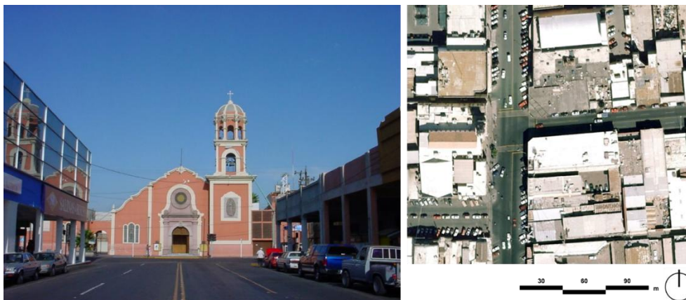
Figura 4. Imágenes del área de estudio antes de intervención (2012)
