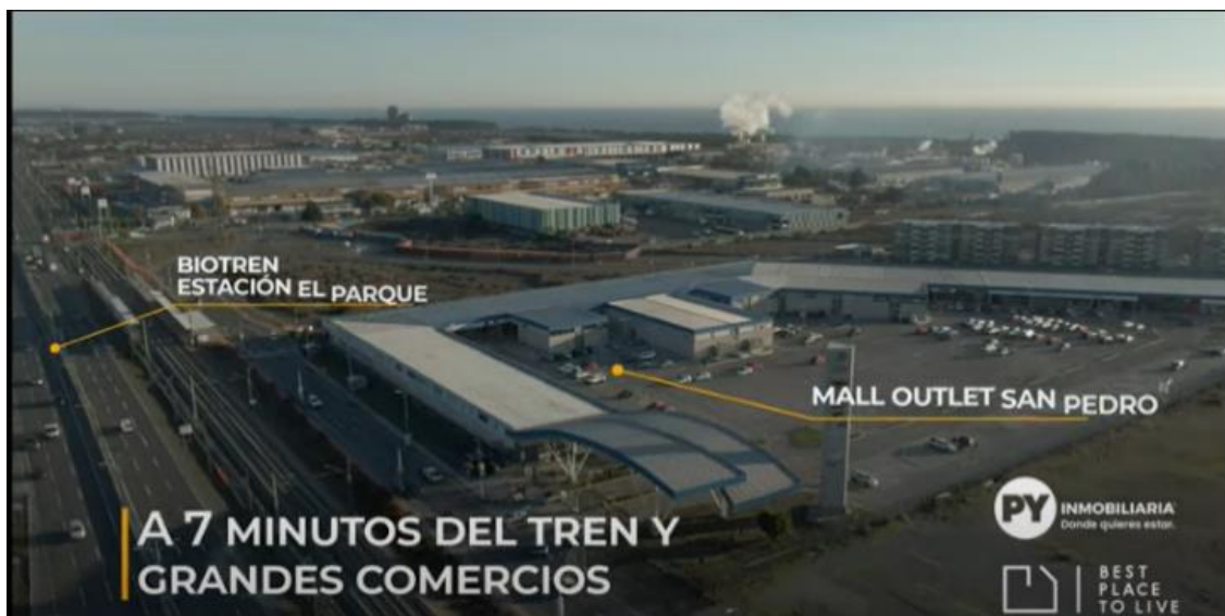
Figura 5. Relevo cercanía a infraestructura y servicios
