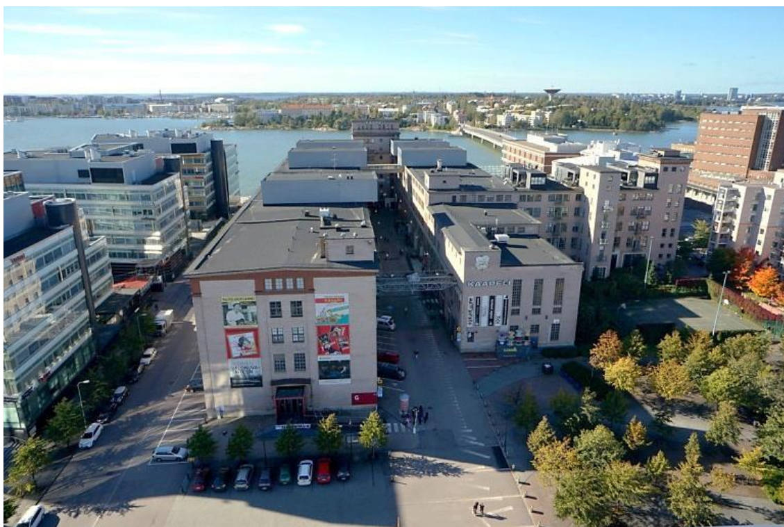
Figura 2. Vista aérea de la Cable Factory en 2020
