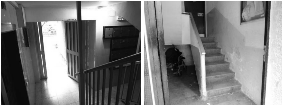
Figura 6. Vista del núcleo de comunicación vertical en los bloques Nº 5 y 25
