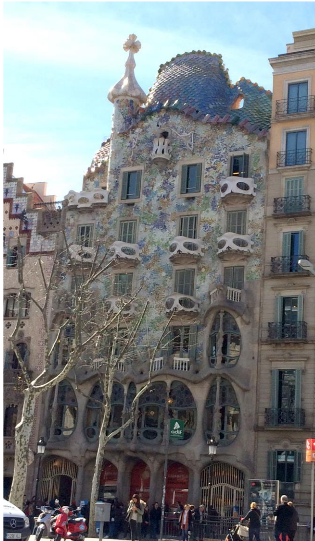
Figura 11. Imagen actual de la fachada de Casa Batlló al Passeig de Gràcia
