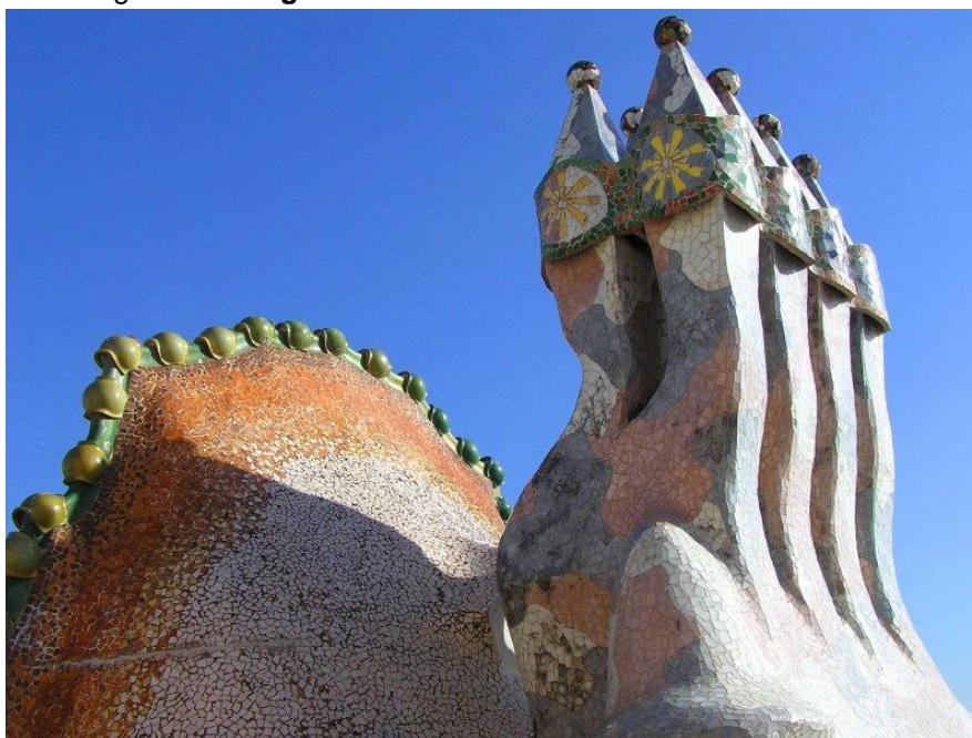
Figura 13. Imagen de la salida a cubierta de las chimeneas
