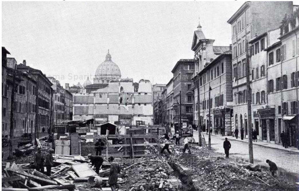
Figura 2. Obras de demolición de la "Spina di Borgo "
