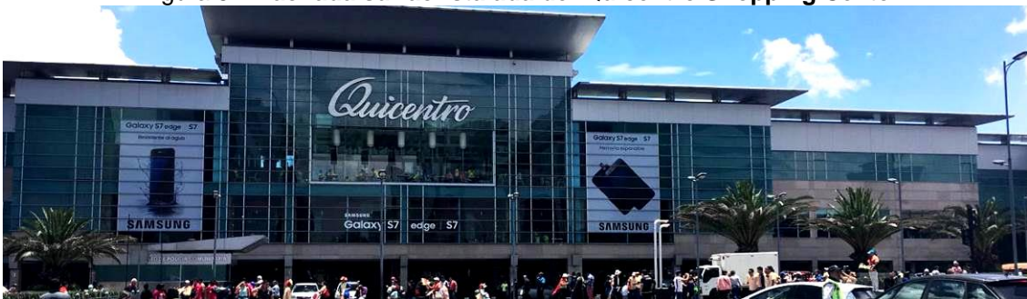
Figura 51. Fachada sur acristalada del Quicentro Shopping Center
