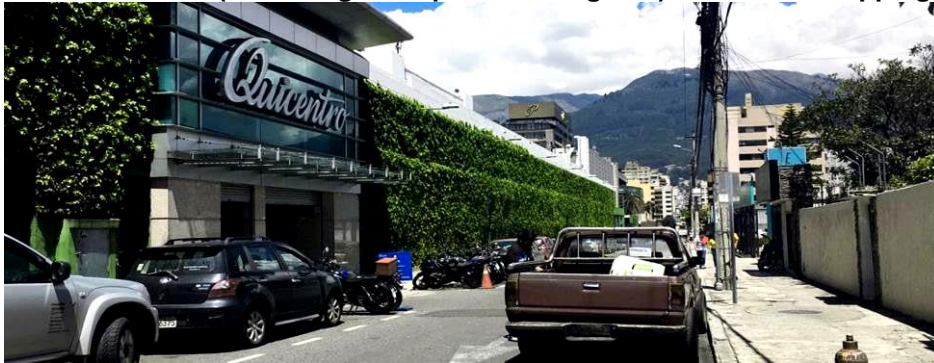
Figura 53. Fachada sur (muro ciego con portón de ingreso) Quicentro Shopping Center
