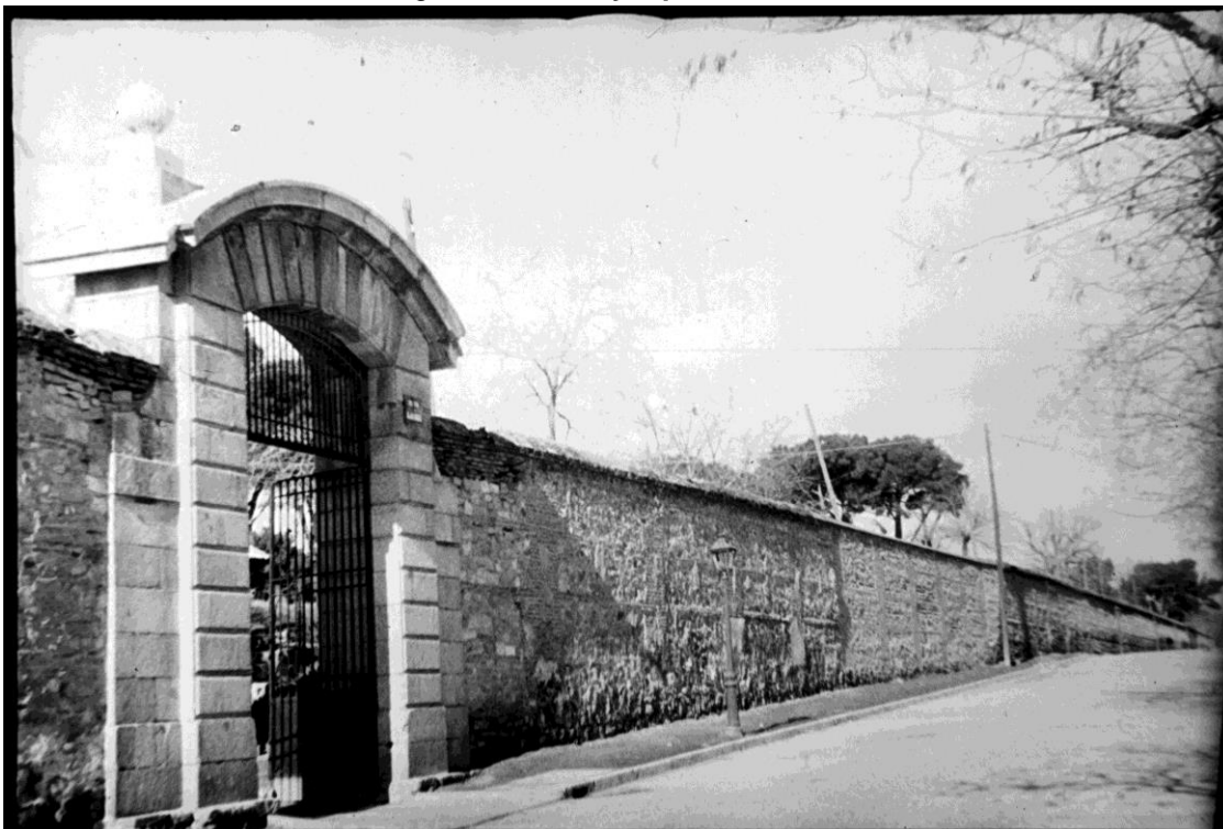
Figura 1. Puerta y tapia del Retiro
