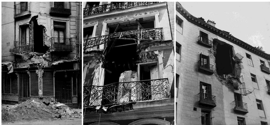
Figura 18. Efectos de los impactos de proyectiles de artillería en los edificios de Madrid.
