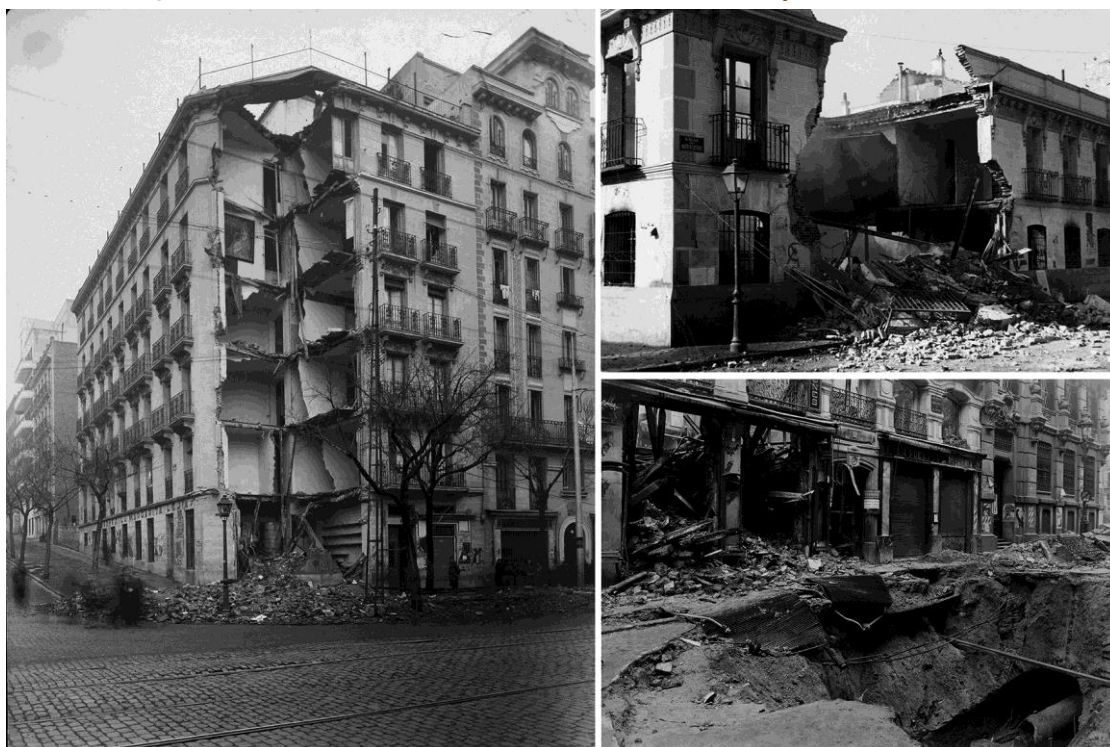
Figura 19. Efectos de bombas de aviación en los edificios y calles de Madrid.
