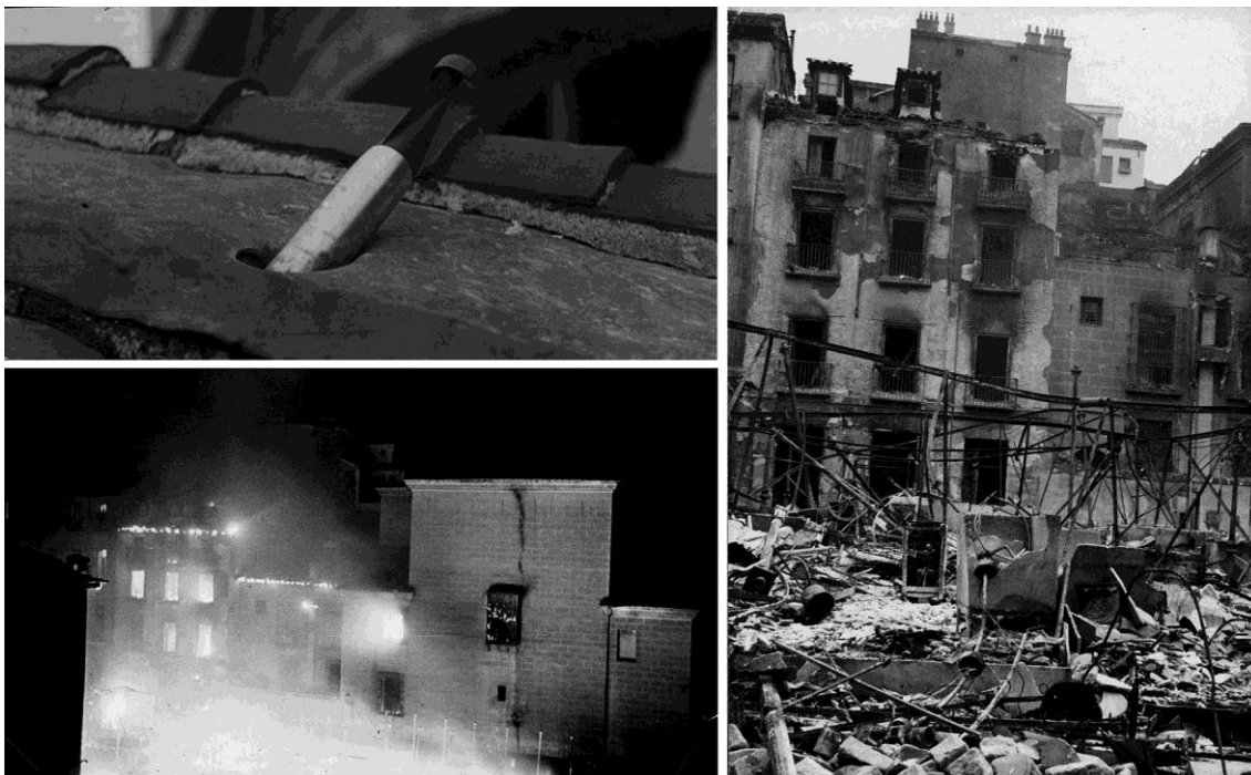
Figura 20. Efecto de las bombas incendiarias en los edificios de Madrid.
