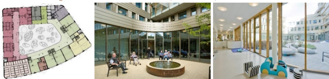
Figura 6. Edificio De Bouwmeester (2013, Utrecht), LEVS Architecten
