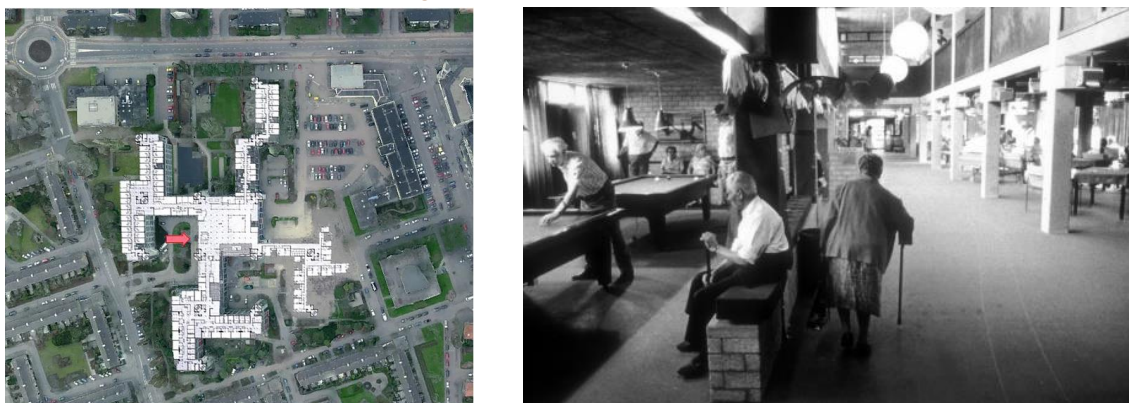
Figura 1. Edificio De Drie Hoven
