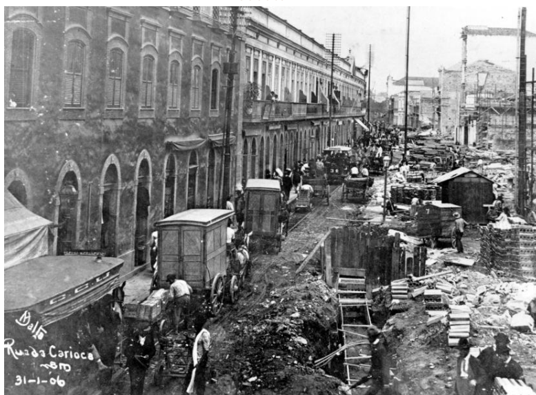
Figura 4. Demolições no centro do Rio de Janeiro durante a reforma de Pereira Passos, no início do século XX
