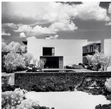
Figura 6. Casa Prieto López (1948), vista de la fachada frente a la alberca. Luis Barragán
