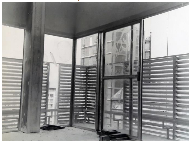
Figura 2. Interior del salón en esquina durante la construcción del edificio, 1964
