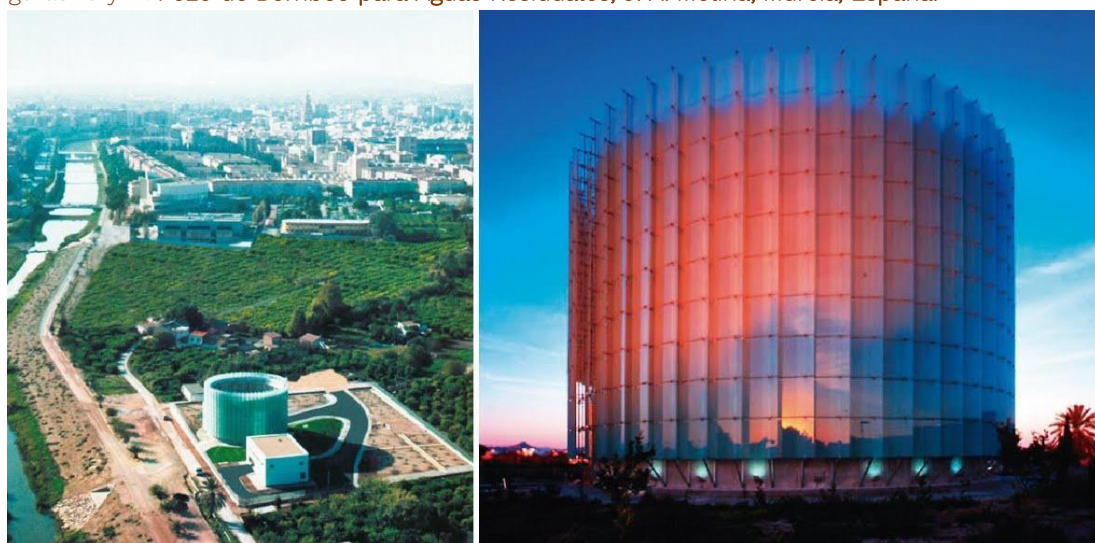
Figuras 10 y 11. Pozo de Bombeo para Aguas Residuales, J. A. Molina, Murcia, España.
