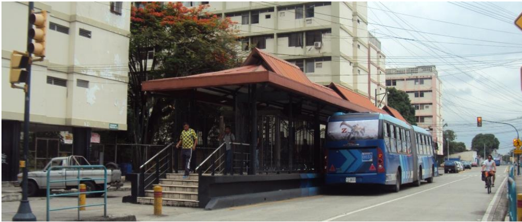
Figura 5. Parada tipo caseta, calle Machala, 2018
