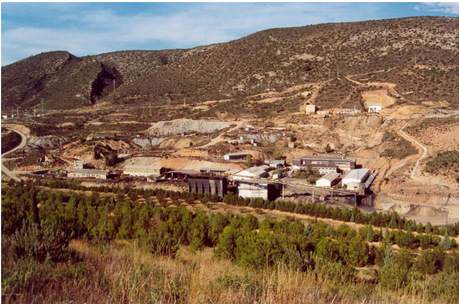
Fig. 2 Vista exterior de Mina de interior La Oportuna, en explotación años 80. Fuente: Archivo fotográfico Antonio Pizarro
