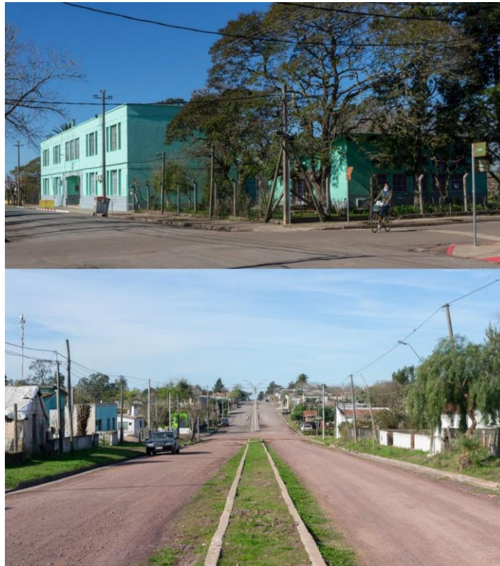
Fig. 11. Arriba: Edificio escolar Abajo: Doble vía sin infraestructura – Fotos: Diego Medero, 2020.
