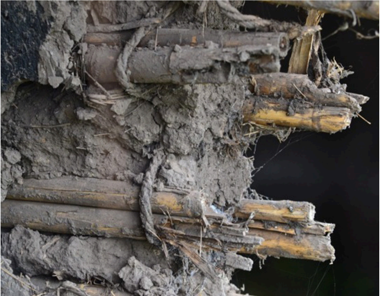
Fig. 10 Detalle del Bahareque en la ciudad sagrada de Caral, Perú. Cultura que se desarrolló entre 3000 y 1800 a. C. (Arcaico Tardío y Formativo Inferior) (Shady Solis, 1997). Es la más antigua de las civilizaciones prehispánicas, superando en 1500 años a la civilización Olmeca, otro importante foco civilizatorio situado en Mesoamérica. Fuente: Cortesía Lucía Garzón Castañeda.
