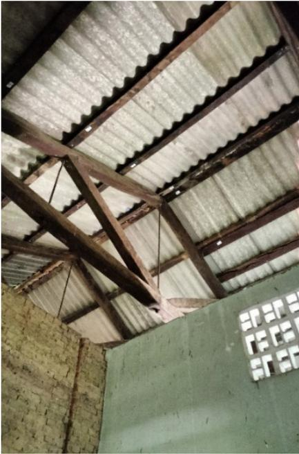
Fig. 21 Interior de uno de los volúmenes de la estación del ferrocarril de Apulo. Detalle de cubierta, muro de ladrillo y celosía en fachada. Fotografía propia.
