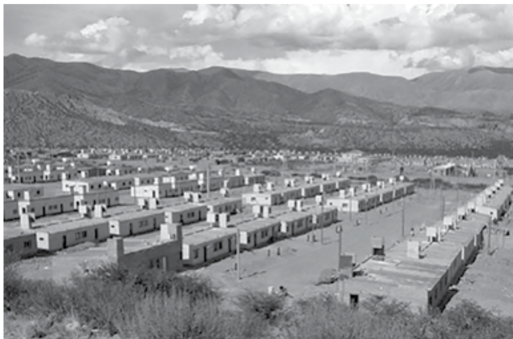
FIG. 03 Operaciones de vivienda pública cerca de Tilcara Fuente: Reproducido de Sabaté Bel y Martínez de San Vicente (2011:111)
