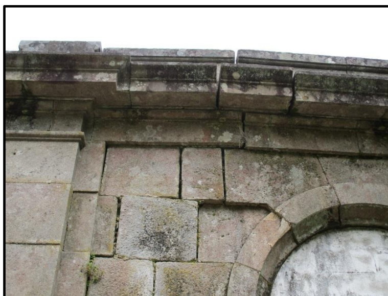
Fig. 11 Movimiento de sillares en el muro sur. Fuente: Archivo personal de los autores
