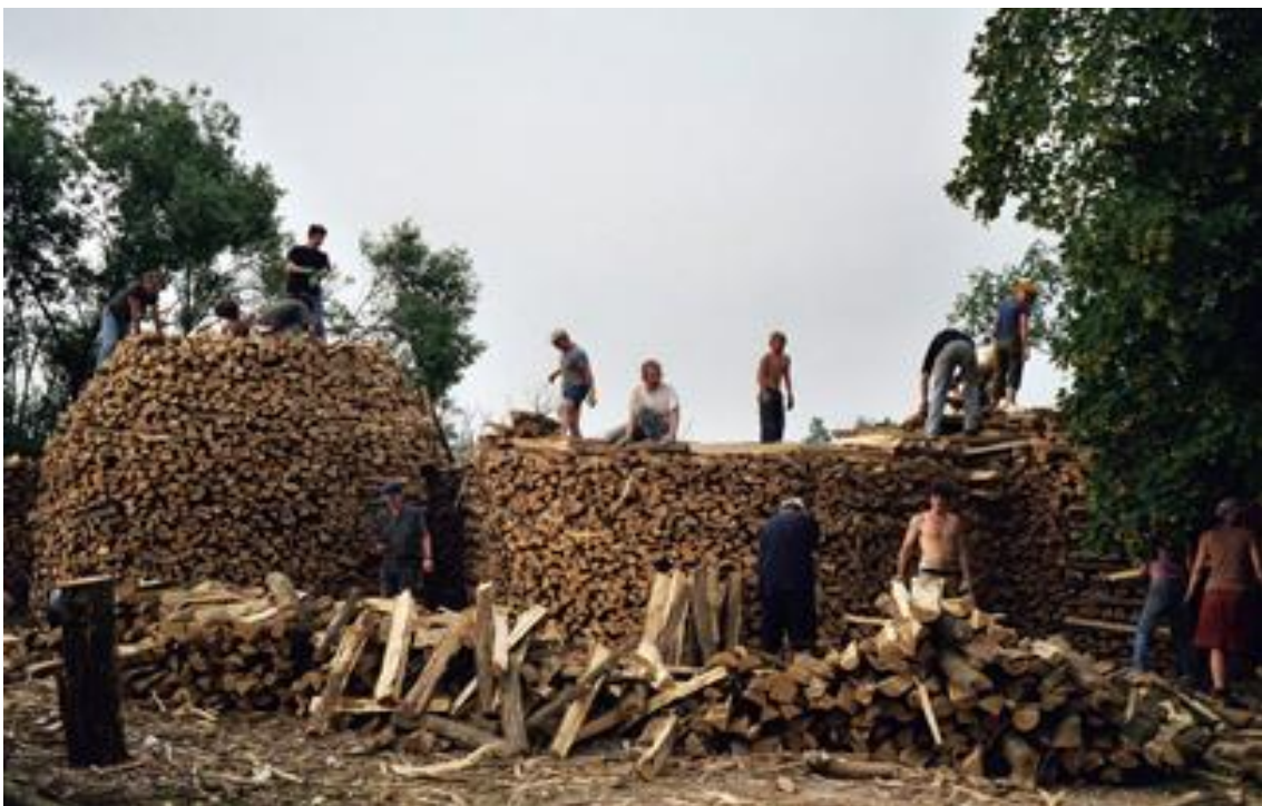
Fig. 2 Proceso de construcción del taller 1:1 WOOD WORKS Fuente: Archivo D-ARCH / ETH-Z / Deplazes, A (2003)
