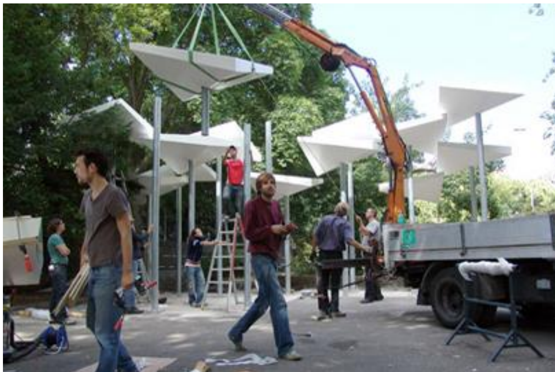
Fig. 10 Montaje de las estructuras. Fuente: Archivo D-ARCH / ETH-Z, Deplazes, A (2005)
