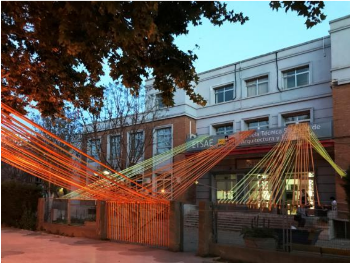
Fig. 8: A.I., una vez finalizada la fase de montaje.
