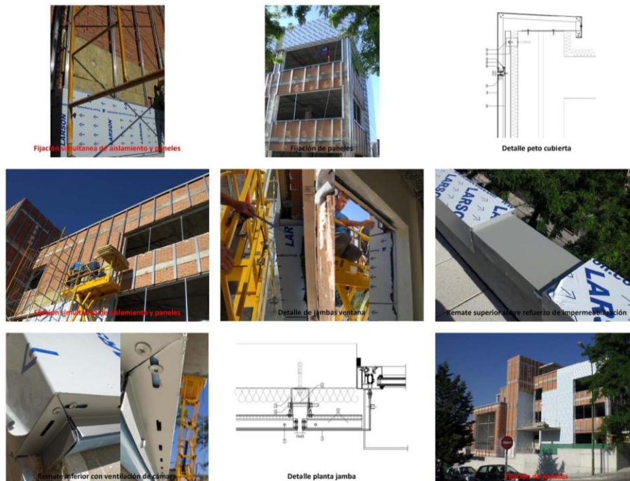
Fig. 5. Fotogramas de video de fachada ventilada de paneles composite de aluminio. Fuente: Elaboración propia (2017)
