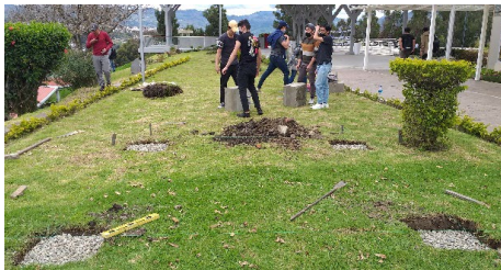
c) Replanteo en el terreo y excavación
