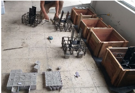
a) Estructura interna de los dados
