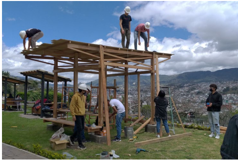
a) Armado de cubierta: corte de tablas de yamila
