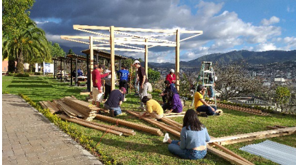
c) Trabajo en el lugar: puesta de pórticos
