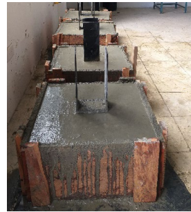
b) Fundición con hormigón 240kg/cm 2
