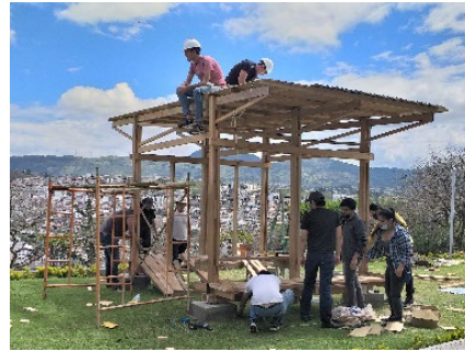
b) Armado de cubierta: colocación de zinc
