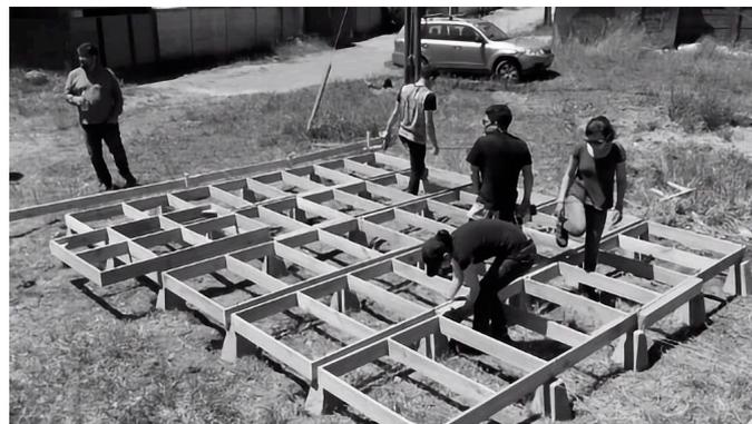
Fig. 3 Instalación de bastidores y vigas maestras. Fuente: Archivo Taller de Barrios (2017)
