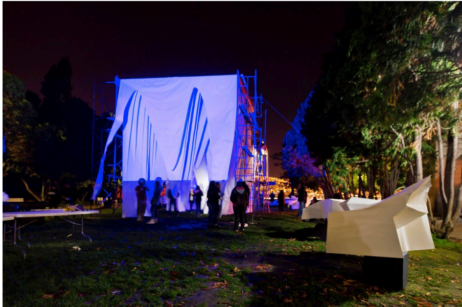
Fig. 26 Experiencia de aprendizaje módulo materialidad. Proceso izamiento de "Mar de plástico", patio central. UTFSM, Valparaíso. 2023. Fuente: archivo T1
