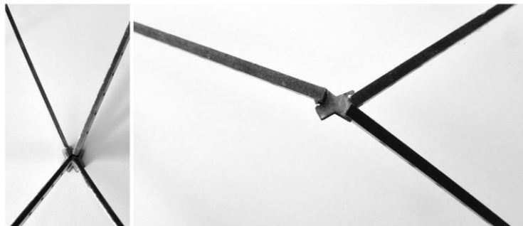
Fig 5. Nudo de encuentro de barras del esqueleto estructural. La complejidad de la unión obliga a diseñar una pieza especial que una las diferentes barras que se encuentran formando ángulos diferentes.
