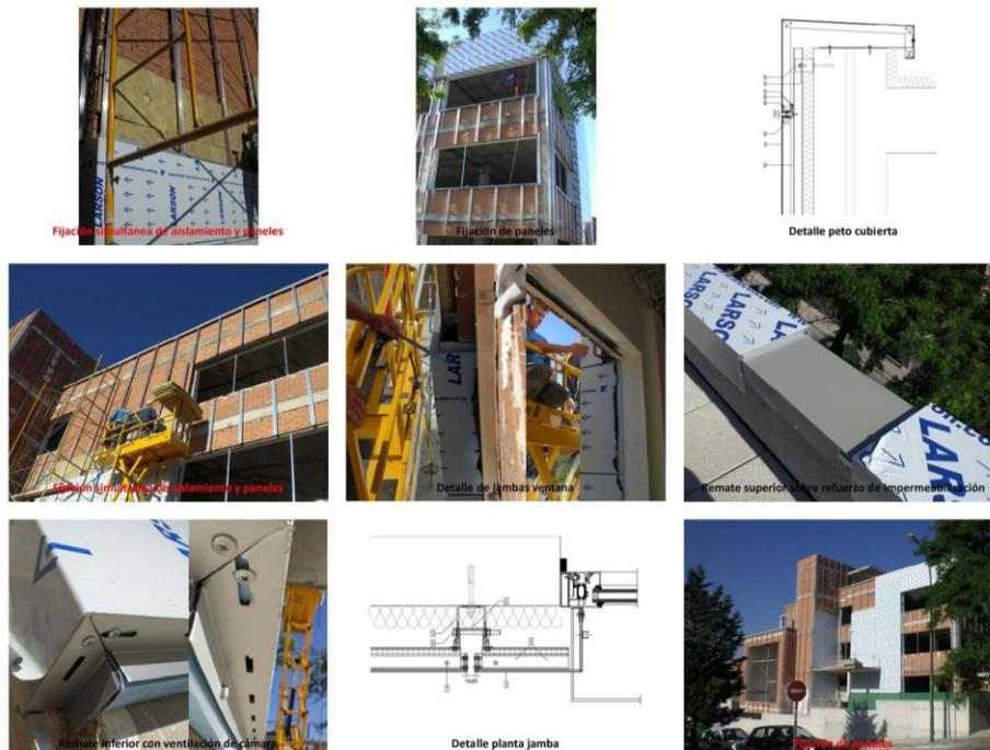
Fig. 5. Fotogramas de video de fachada ventilada de paneles composite de aluminio. Fuente: Elaboración propia (2017)
