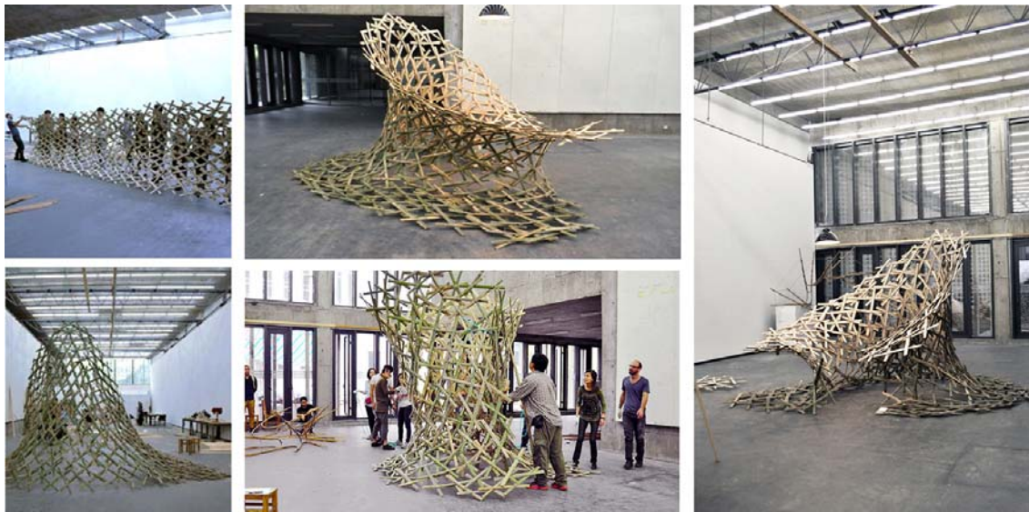
Fig. 3 Resumen gráfico del proceso de puesta en obra. Lo que en principio parecía una superficie ligera, como un tejido, tuvo que ser transportado por un gran grupo de estudiantes. El montaje se realizó con ayuda de poleas. Fuente: archivo personal de los autores (2015)
