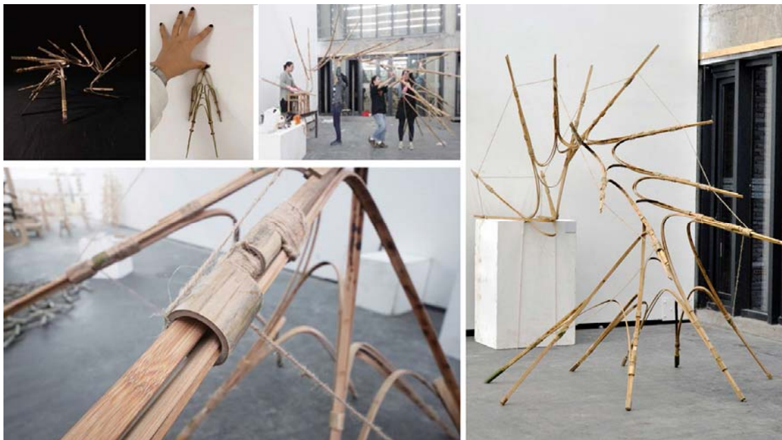
Fig. 6 Resumen gráfico de la propuesta “介”字造(介-composing). A escala 1:20, cortezas de bambú en torsión continua unidas con gomas. A escala real las estudiantes plegaron listones de bambú con agua hirviendo hasta que consiguieron la forma de cada pieza. La puesta en obra fue como si se tratara de domar a un dragón. Fuente: archivo personal de los autores (2015)
