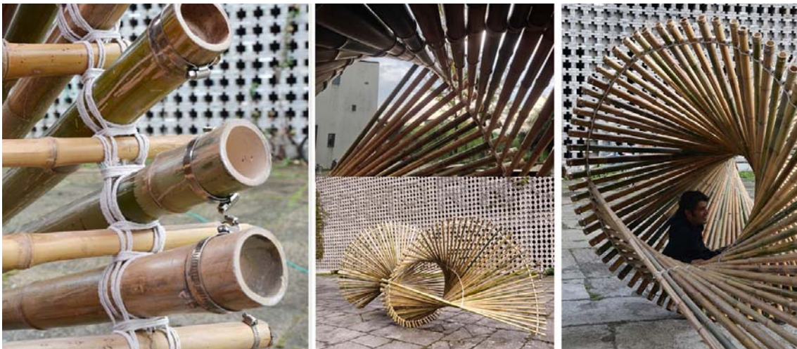
Fig. 5 El cambio de escala. En maqueta la uniónla podía hacer un nudo simple. A escala real, las uniones fueron cuidadosamente desarrolladas para resistir los esfuerzos a tensión. Fuente: archivo personal de los autores (2015)
