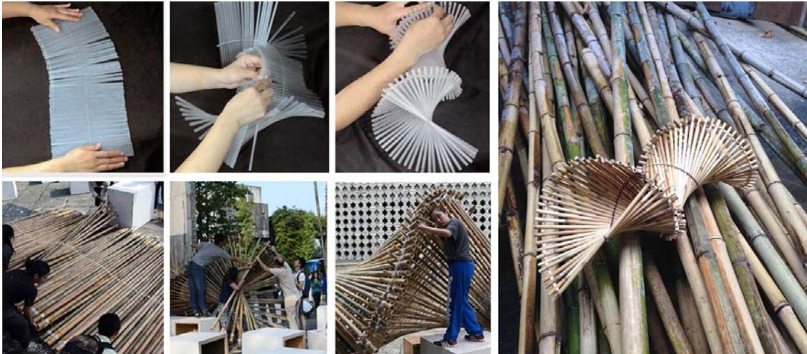
Fig. 4 Resumen gráfico del proceso de fabricación del primer modelo en tubos de plástico, que posteriormente se tradujo en bambú. Nuevamente, el cambio de escala y materialidad sorprende al estudiante a la hora de ensamblaje del prototipo final. Fuente: archivo personal de los autores (2015)
