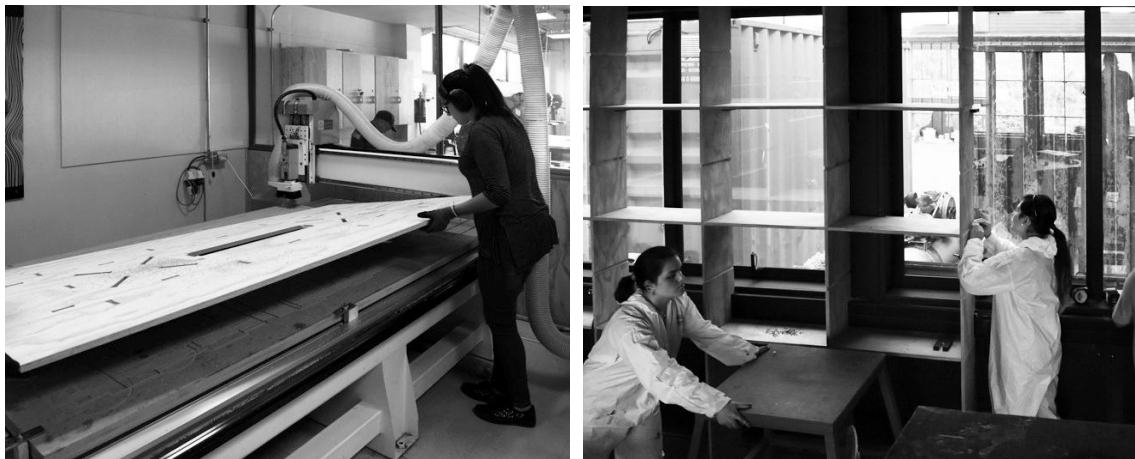
Fig. 3 y 4 Fabricación y montaje del nuevo espacio del Taller de Práctica.
