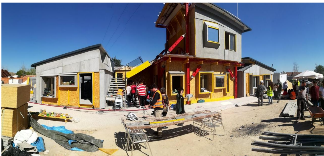
Fig. 6 Vista general del taller con alumnos de la Escuela de Arquitectura de la UAH. Centro Sociocomunitario. Parcela 37B Sector 5. Cañada Real Galiana. Madrid. Foto: Recetas Urbanas. (2019)
