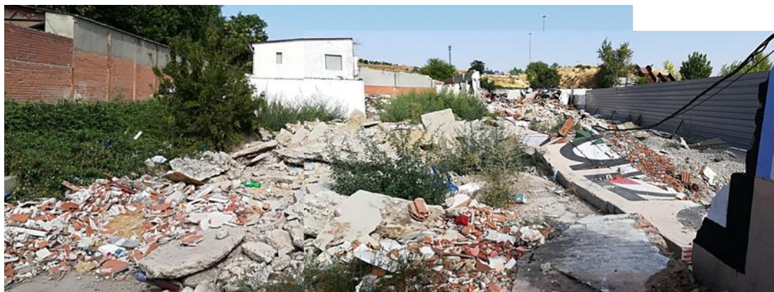
Fig. 2 Estado inicial previo al replanteo. Parcela 37B Sector 5. Cañada Real Galiana. Madrid. Foto: Comisionado Ayuntamiento de Madrid. (2018)
