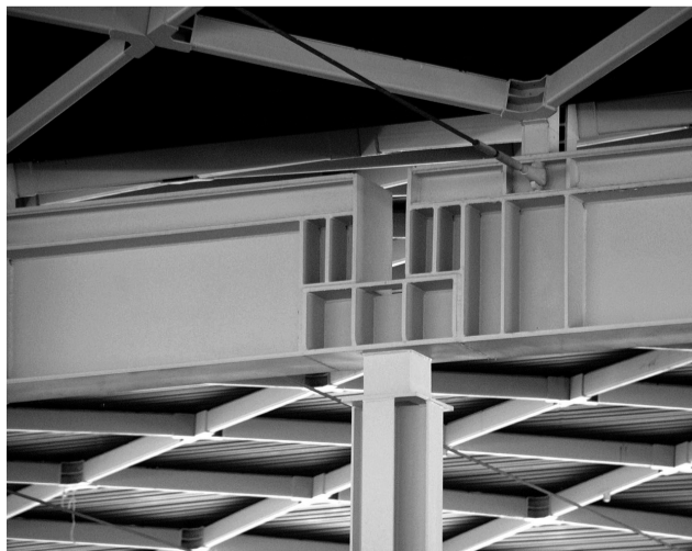
▼ FIG. 2. Obra en construcción
