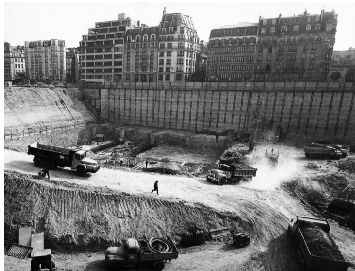
▲ Excavación para la construcción del Centro George Pompidou, 1972. París
