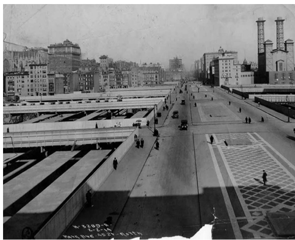
Fig. 1 Park Avenue, 1914. Vista al norte desde 45th Street
