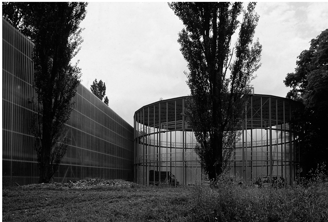
▲ FIG. 1. KRISCHANITZ, A.1988. An der Traisen Pavilion en St. Pölten durante su construcción. Foto: Margherita Spiluttini. Fuente: AZW. Estudio Krischanitz.
