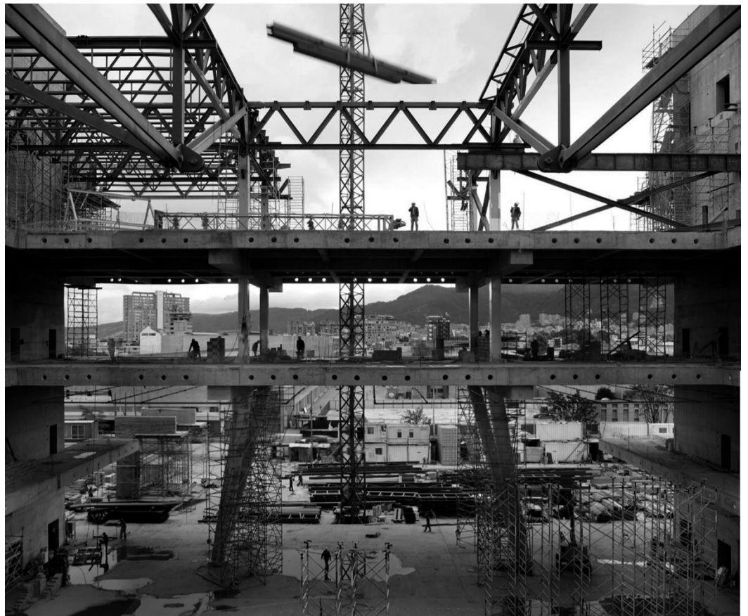
A Ágora-Bogotá. La construcción es un compendio de estructuras avanzadas, metálicas y de hormigón, que se adaptan al límite de las capacidades de las constructoras locales. © estudio Herreros
