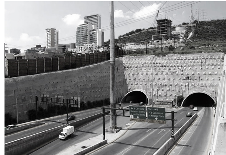
Fig. 13. Salida sur del túnel Loma Larga en San Pedro Garza García. Fuente: México en fotos.
