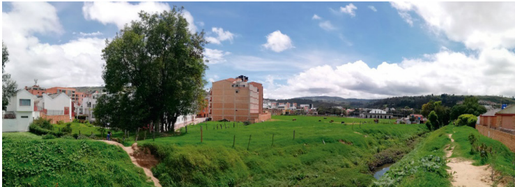
Fig. 04. Falta de integración de dos sectores con un crecimiento vinculado al río. Fuente: Fotografía propia
