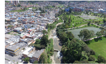
Fig.14. Imagen arborización ronda Río Fucha y Parque San Cristóbal.
