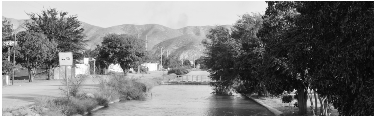
Fig. 21. Canal de Sacramento. Detalle de los cruces y edificaciones frente al curso artificial de agua. Fotografía del autor
