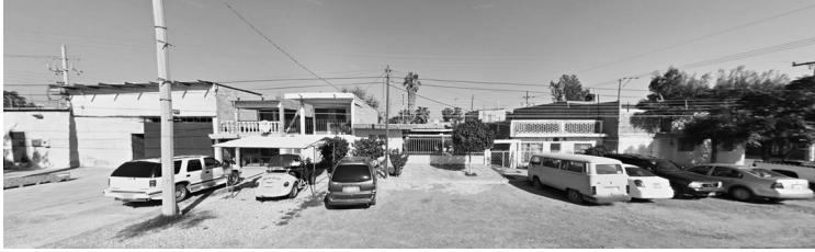
Fig. 20. Frentes de fachada frente al Canal de Sacramento en la ciudad de Gómez Palacio Durango. Fotografía: Google street view
