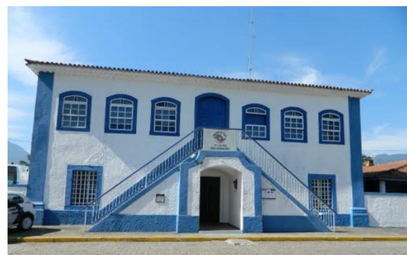
Fig.08. Casa de Câmara e Cadeia de São Sebastião, construída no
