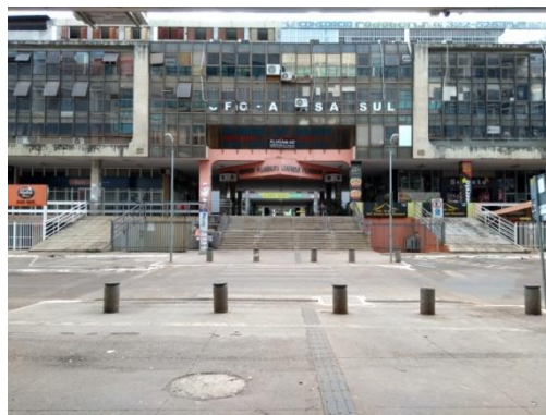
Fig.15 Acesso a trecho do corredor central viabilizado por escada. Fonte: Elaboração própria.
