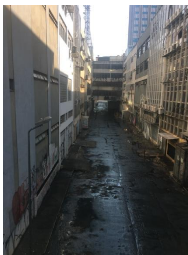
Fig. 4 Vias subterrâneas formando becos sem saída. Fonte: Elaboração própria
